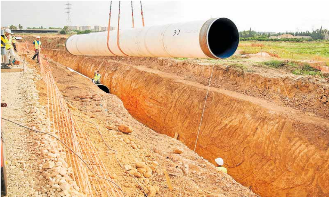
Colocación de una de las tuberías arteriales, ayer en el término de Xirivella.1P
